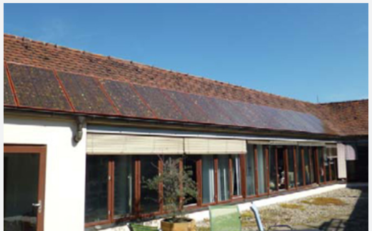
Photovoltaik am Denkmal (Foto: Stadt Nürnberg)
