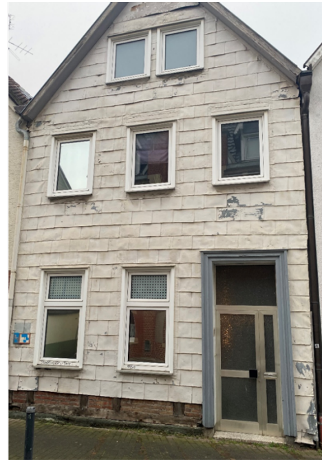
Kunststoff-Fenster in historischen Gebäuden
