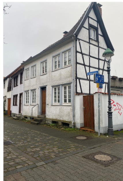
Unsanierete Gebäude in stadtbildprägenden Sichtachsen bzw. Raumkanten
