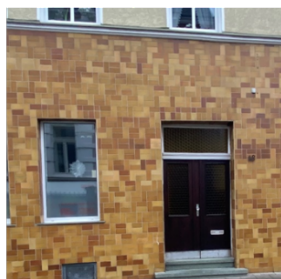
Nicht baualtersgerecht sanierte Erdgeschosse
