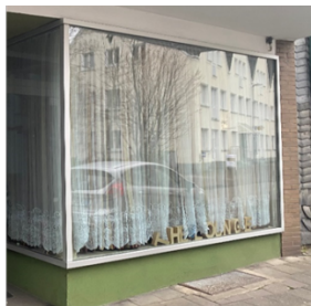
Nicht baualtersgerecht ausgeführte Ladenzeilen
