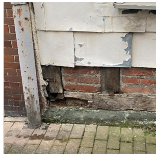
Unsachgemäß verkleidete Fachwerkfassaden
