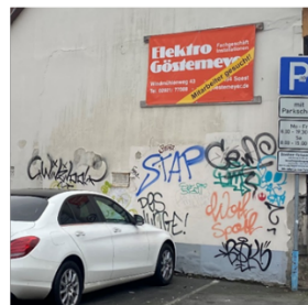
Vandalismus an Fassaden
