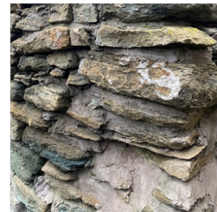
Schäden an Grünsandstein-Mauerwerk
