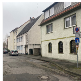
Randbereiche mit augenscheinlichem Sanierungsstau
