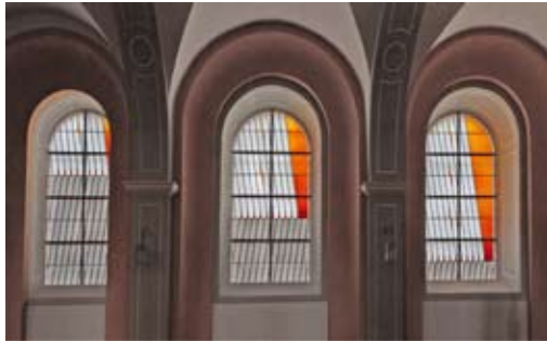
➔ Trier | Zur Hl. Dreifaltigkeit (Jesuitenkirche) acht Schiffenster, je drei Fenster in der nördlichen und südlichen Seitenkapelle, acht Obergadenfenster 2005 - 2012
