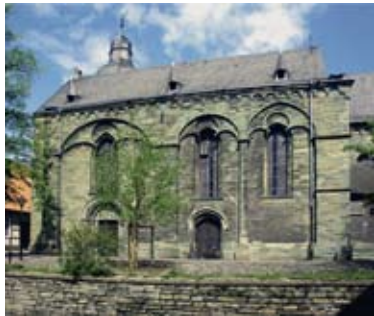
➔ Soest St. Maria zur Höhe (Hohnkirche) Gesamtverglasung (20 Fenster) 1993 - 1997
