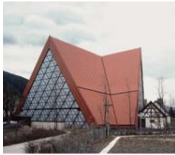
➔ Bleibach St. Georg drei doppelschalige Glaswände 1976
