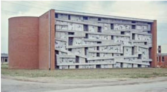
➔ Bergisch Gladbach-Refrath St. Elisabeth (1962) plastische Betonglaswand in der Ostseite 1962
