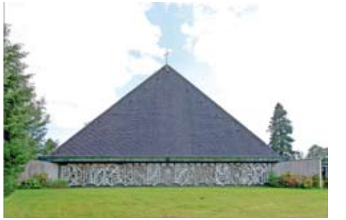
➔ Königsfeld | St. Peter und Paul umlaufende Lichtwand aus Betonreliefplatten und Drahtglas 1972
