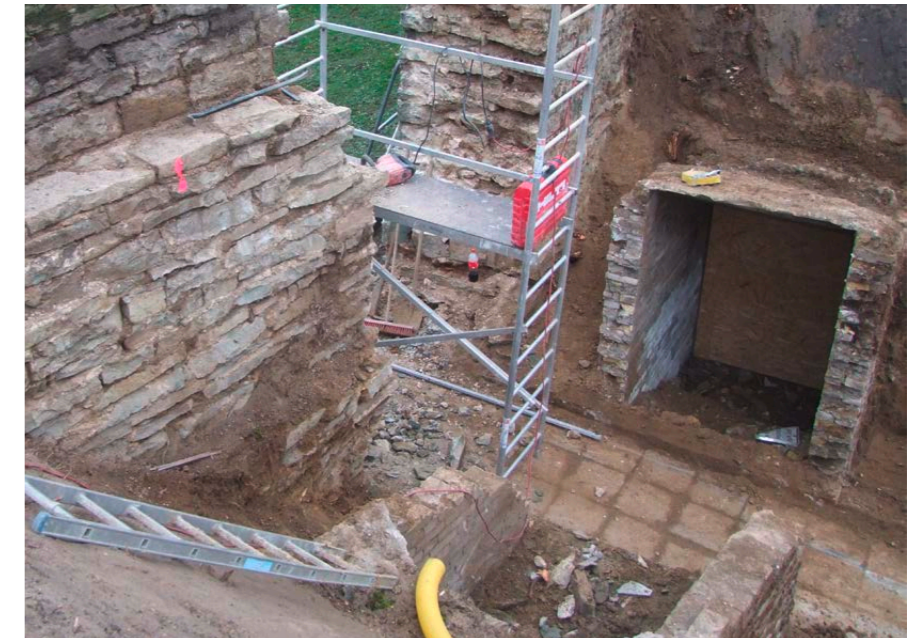
Bei der Erweiterung des Walldurchgangs zur Grünen Hecke legten die Arbeiter Eingänge zu einem alten Luftschutzstollen frei.
