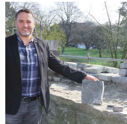
Tobias Trompeter, Abteilungsleiter Immobilienmanagement der KBS, auf der Baustelle an der Wallmauer
