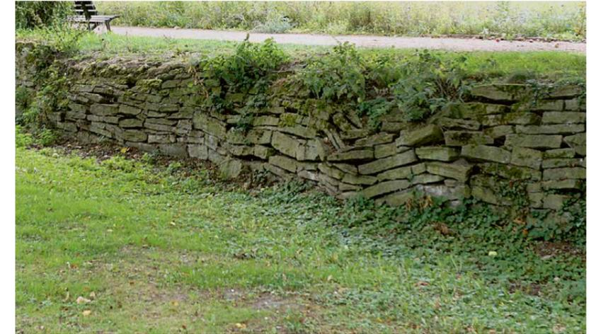
Im Rahmen der Wallsanierung wird auch dieser stark beschädigte Mauerabschnitt erneuert.
