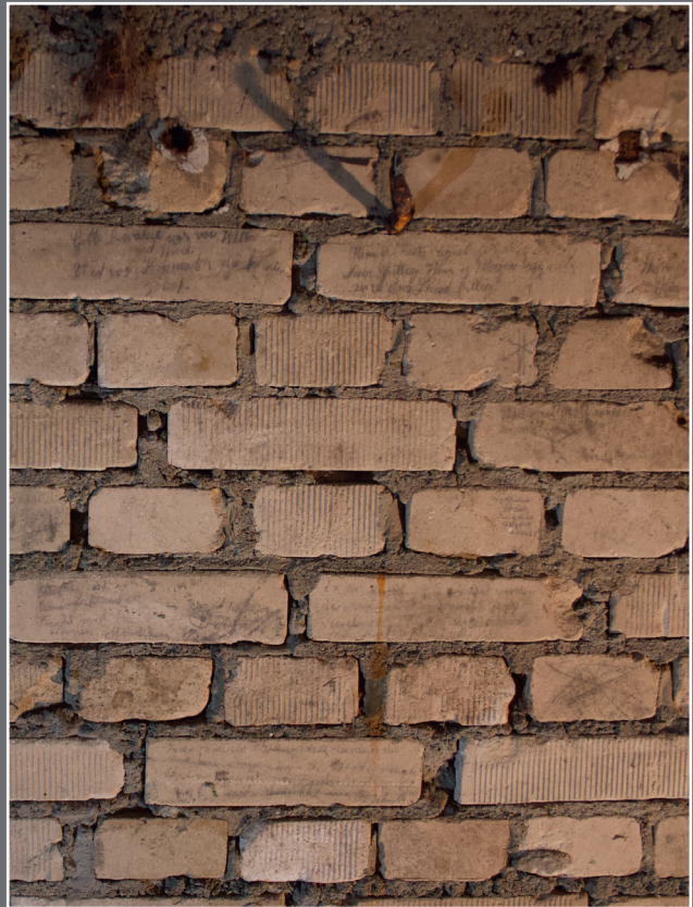
▲ Abb. 7 Mauerabschnitt mit Haken zum Aufhängen von Habseligkeiten und zahlreichen Inschriften auf den Steinen
