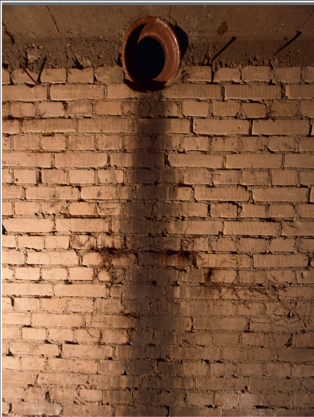
▲ Abb. 6 Heutiger Blick auf eines der Tonrohre zur Entlüftung
