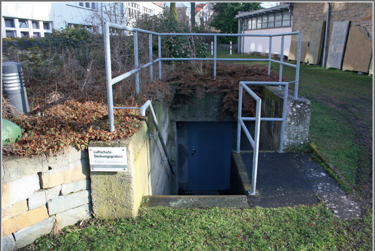
▼ Abb. 2 Zugang zum Luftschutzdeckungsgraben am Burghof. So ähnlich sahen die typischen Zugänge zu Luftschutzdeckungsgräben aus.
