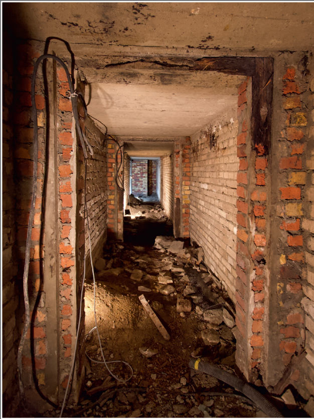
▲ Abb. 4 Heutiger Blick aus der Gasschleuse am Eingang durch den Tunnel in Richtung Schikane
