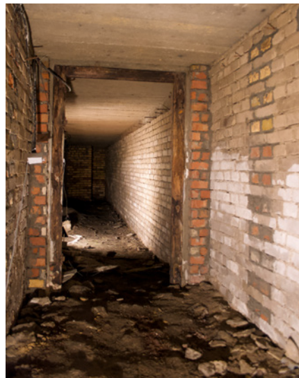
Abbildung 4: Rechts im Bild sind die Reste der abgeschlagenen Türleibung zu erkennen, die weiter hinten eingebaut werden musste. Foto: Verf.
