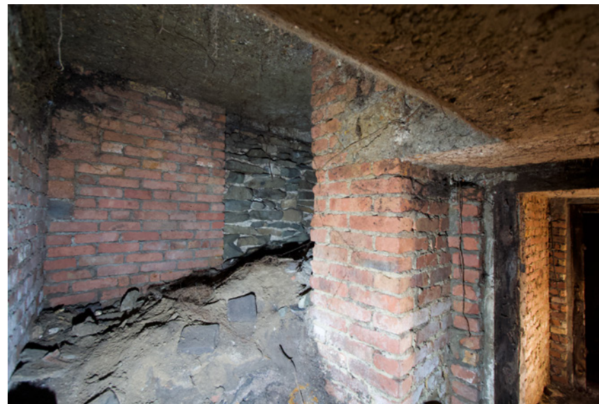
Abbildung 3: Blick hinauf zum mit Bruchsteinen vermauerten Nordwestzugang (Bildmitte). Am Rechten unteren Bildrand ist die Schleuse zu erkennen. Foto: Verf.
