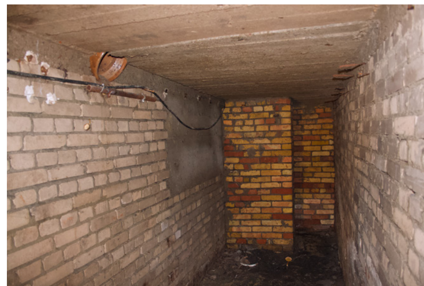
Abbildung 1: Blick in die Südostsektion des Stollens mit seiner Mischung aus Mauerwerk und Betonabschnitten. Foto: Verf.
