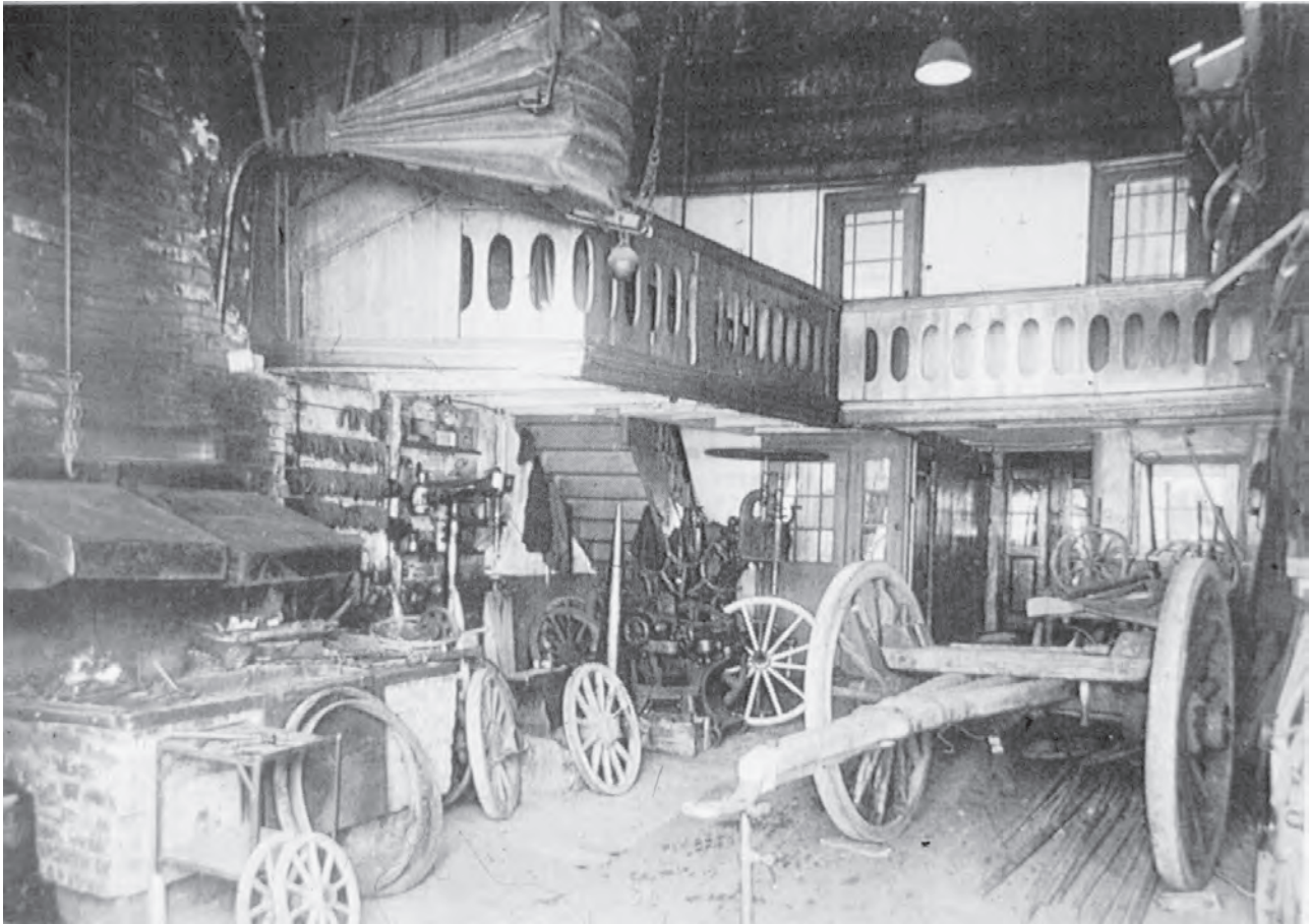
Abb. 10 Schmiedehaus des 16. Jahrhunderts in der Lübecker Mühlenstraße, die Esse befand sich an der Brandmauer in der Diele.
