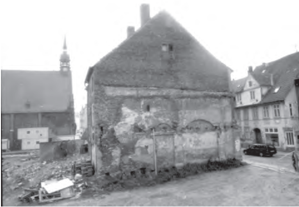
Abb. 2 Stralsund. Nordwand des Hauses Wasserstraße 54 mit Resten mittelalterlichen Mauerwerkes.
