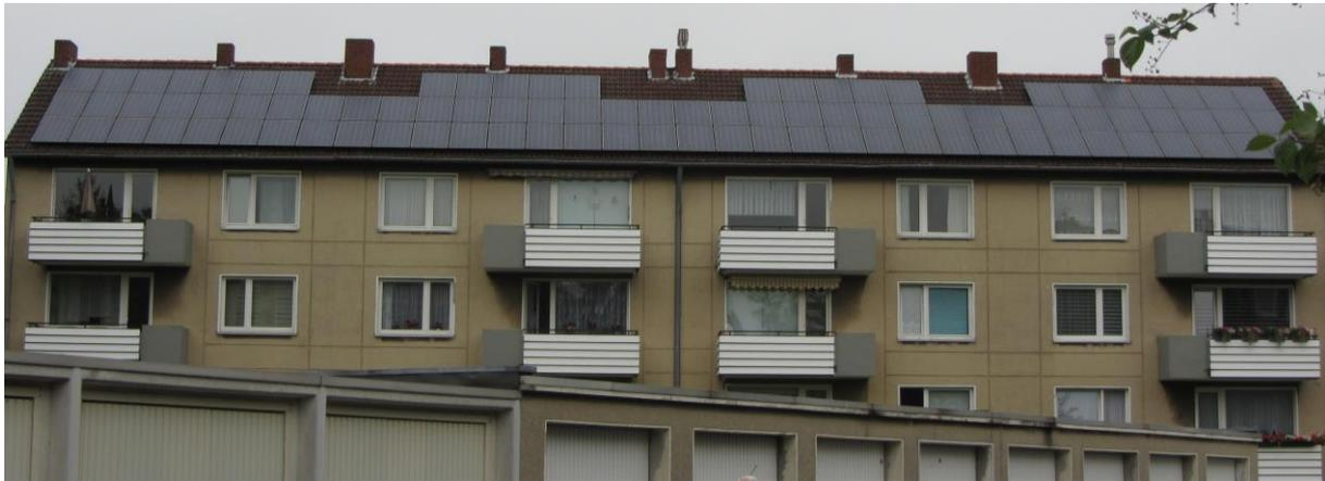
**Abbildung 54: Installierte PV-Anlage im Quartier Gotlandweg (Quelle: eig. Foto 2016).**
