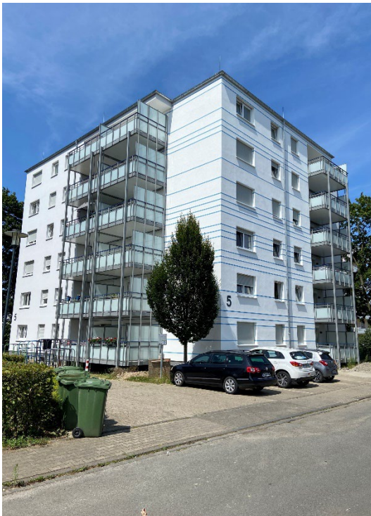
Energetische Gebäudesanierung Bresinaweg
